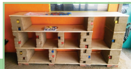
Réalisation du banc en terre crue
